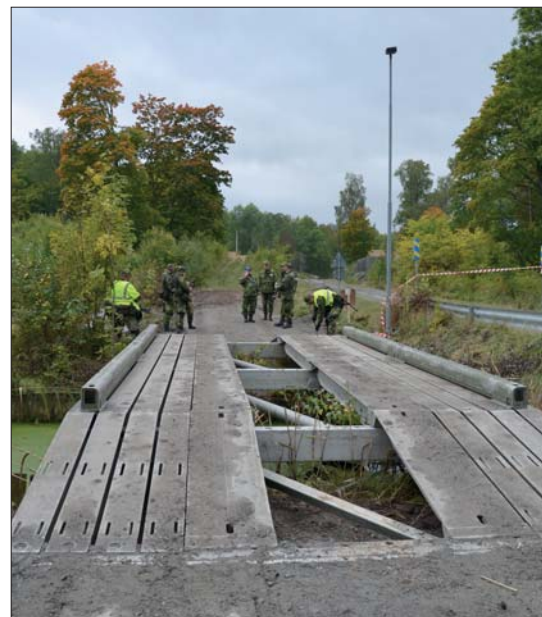
Hemvärnssoldater bygger tillfällig bro på Kungsängens övningsfält.
